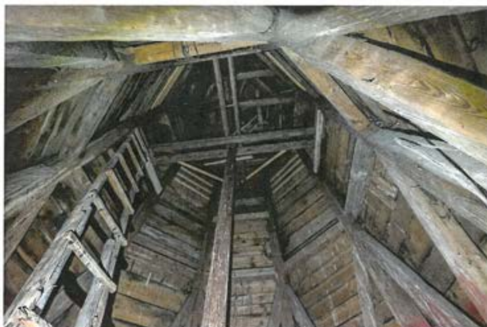
Fot. 16 Słupy zewnętrzne z zastrzałami oraz król wieży usztywniony kleszczami na wysokości powyżej 500 cm.
