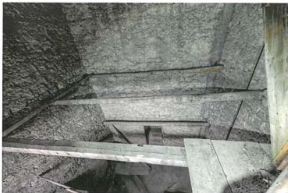
Fot. 6 Belki stropowe poziomu +17.99 m,
