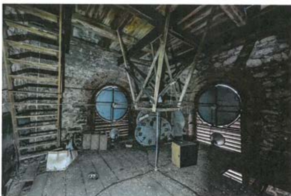
Fot. 12 Klatka schodowa pomiędzy poziomami +26,00 m- +30,15 m
