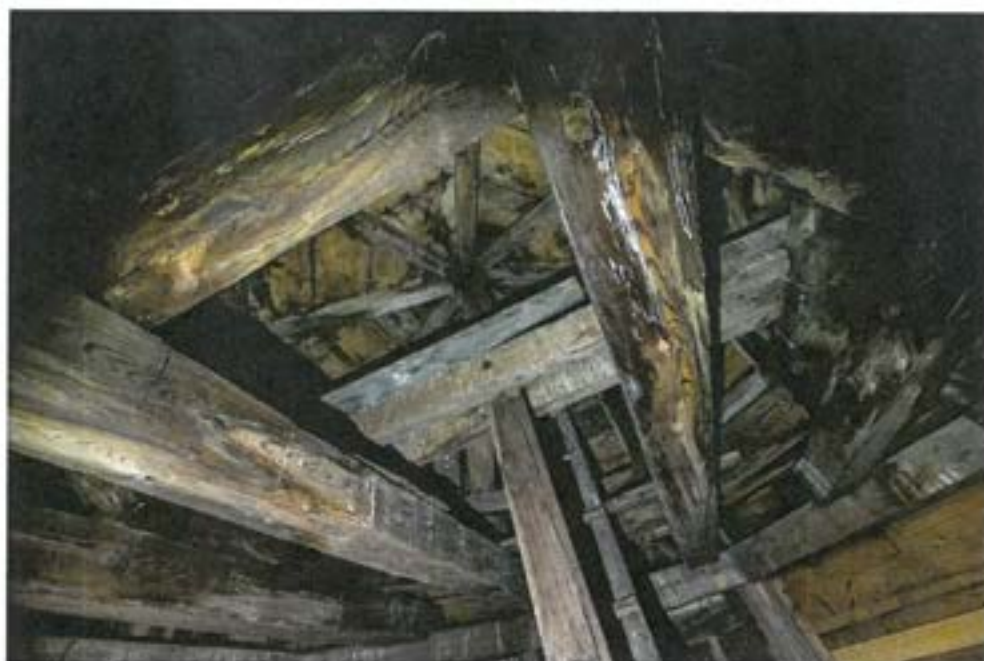
Fot. 19 Podwaliny pod konstrukcję helmu górnego oparte na belkach obwodowych słupów helmu dolnego
