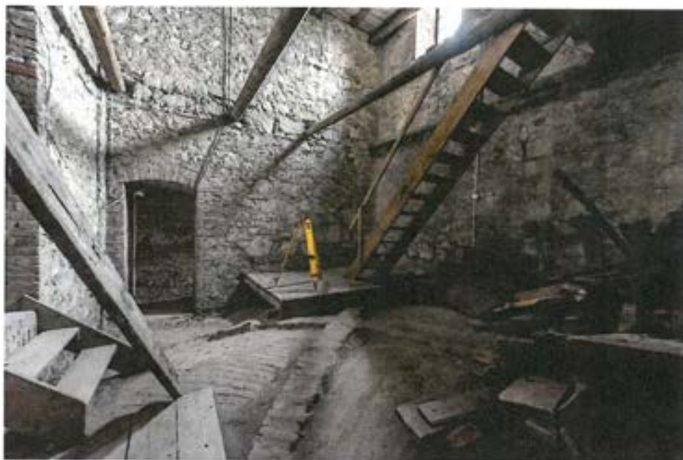
Fot. 1 Widok na klatkę schodową w poz. +12.00 m
