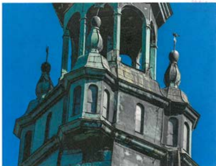
Fot. 1 Zasłonięte otwory okienne
