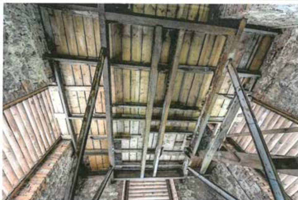
Fot. 11 Konstrukcja stropu i konstrukcji wsporczej w poz. +26,00 m
