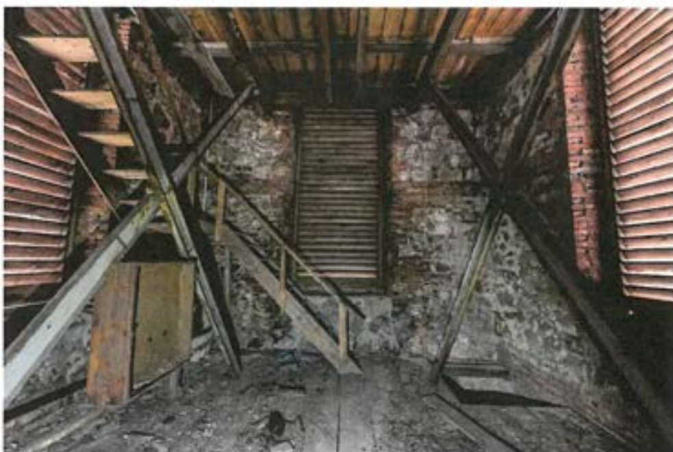
Fot. 8 Deskowanie stropu poz. +21.05 m- widok od góry
