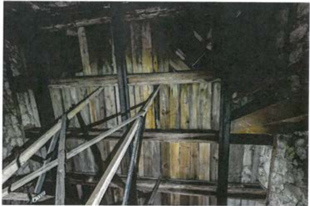
Fot. 14 Pierwotne drewniane podwaliny pod konstrukcję hełmu wieży podparte kształtownikami stalowymi I220
