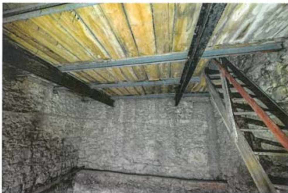
Fot. 7 Konstrukcja stropu w poz. +21.05 m- widok od dołu
