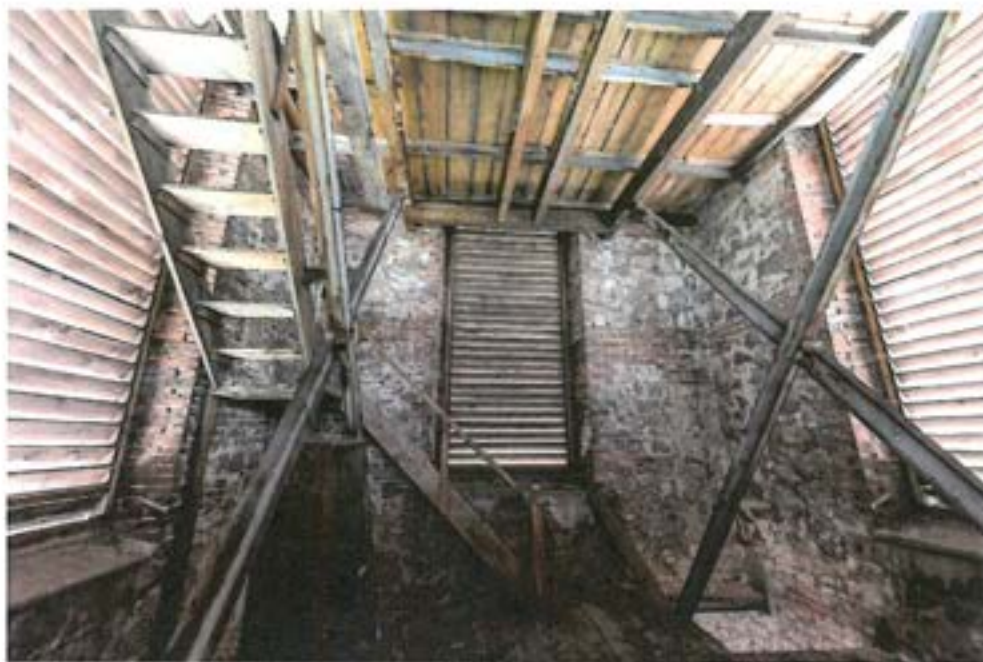
Fot. 9 Strop w poz. +26,00- widok od dołu
